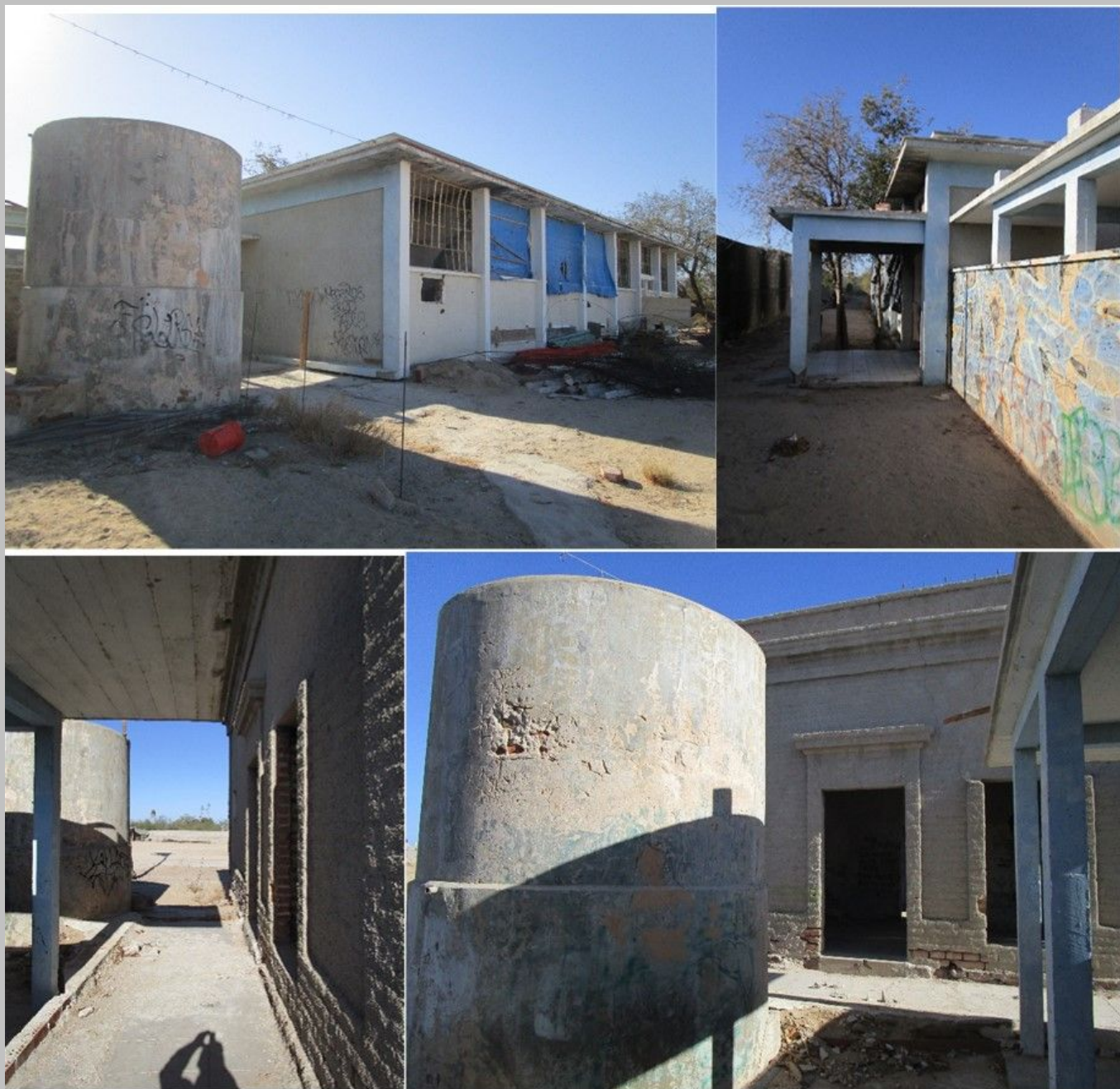
Tanque de almacenamiento de agua entre la antigua casona de Inalámbrica y las oficinas de telégrafos de la década de 1940 (Fotos: Gilberto Piñeda Bañuelos, 30 enero 2025).
