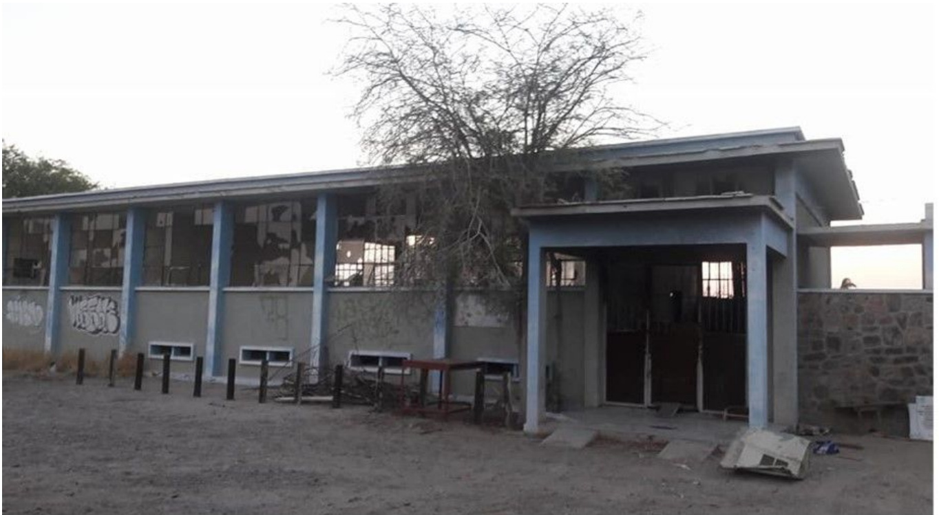
Nuevas oficinas de telégrafos de la inalámbrica en el barrio El Manglito construida probablemente cerca de 1940 (Foto: FB Mayrita Gorosave, 3 junio 2017).
