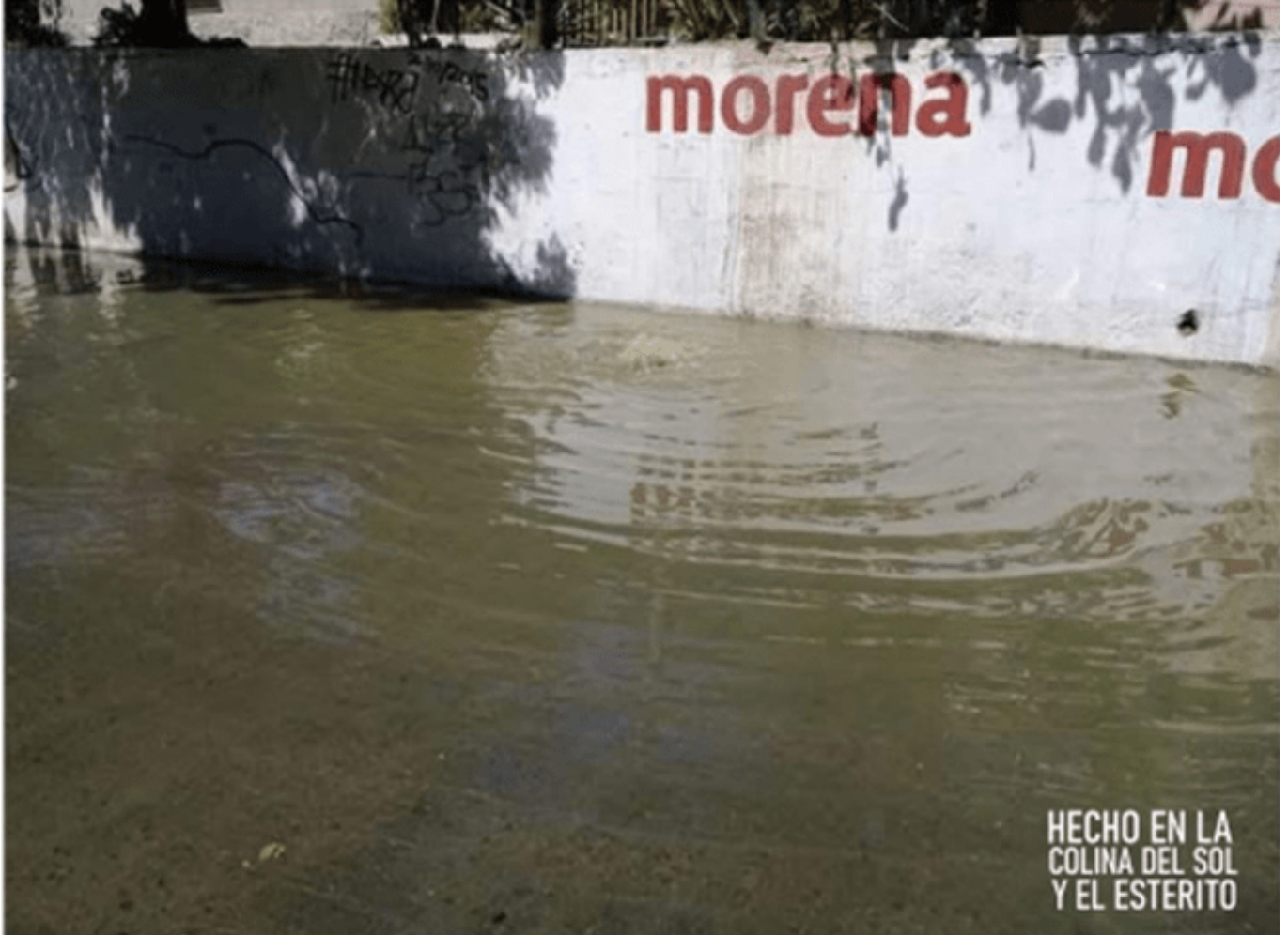
Derrame de aguas negras en el arroyo de la colonia Colina del Sol frente a una pinta de Morena, partido de la presidenta municipal y del gobernador. (Foto: CDP Colina del Sol y Esterito, 2024)
