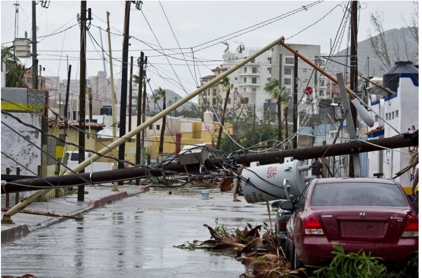
Daños ocasionados por el huracán Odile en septiembre de 2014. Foto: Cortesía
