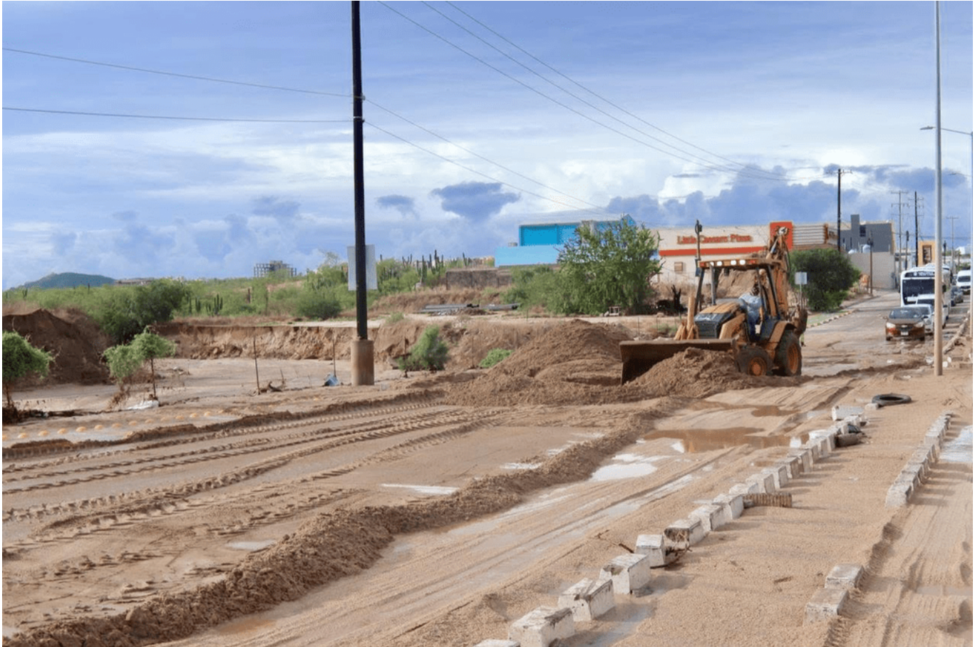
Maquinaria en el municipio de Los Cabos trabaja para liberar cauces de arroyo luego de las precipitaciones ocasionadas por Marie. Foto: Cortesía / Ayuntamiento Los Cabos
